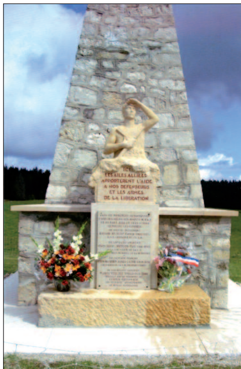
Le Monument de la Prairie entièrement rénové.
